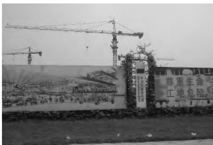
イオンSC工事現場・駐車場8千台
