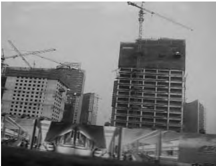
多数の建設中ビル
